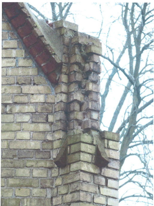
Fot. 58. Zniszczenia cegieł i ubytki w obrębie sterczyzny.
