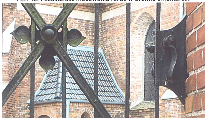
Fot. 42, Fot. 43. Detal furtki zlokalizowanej przy plebanii – klamka i kwiat na łączeniu elementów.
