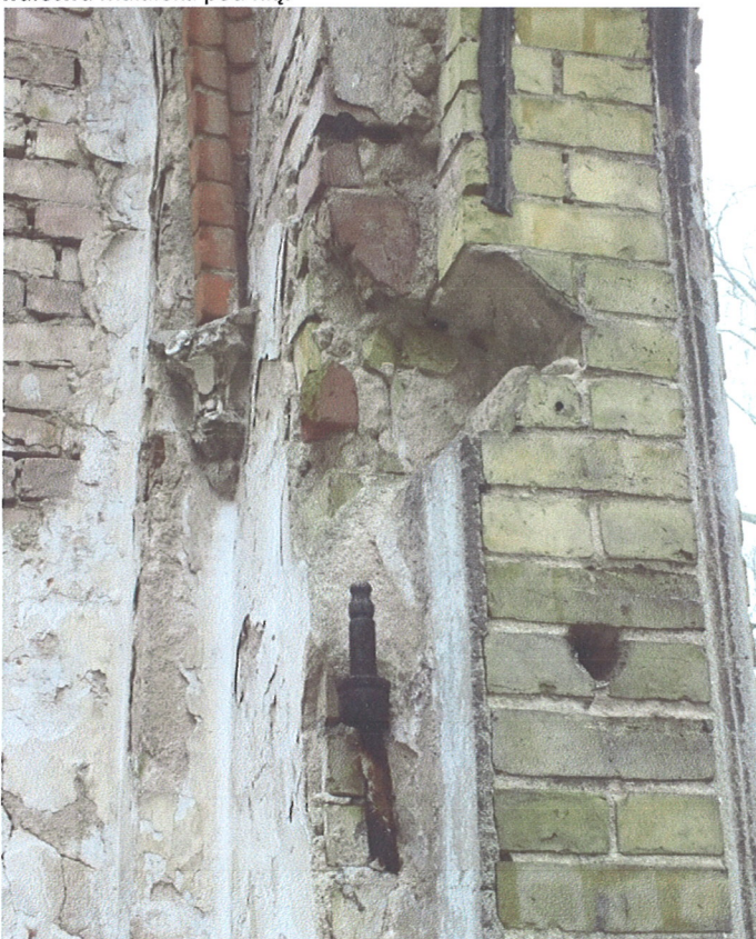
Fot. 56. Światło otworu drzwiowego kaplicy. Widoczne są: miejsce montowania belki nadprożowej drzwi, zawiasy drzwi oraz kotwa okna w nadświetlu.
