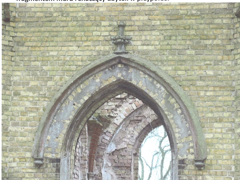
Fot. 49, 50. Dekoracje wokół otworów okiennego i drzwiowego – profilowane obramienie i zdwojony łuk ostry z szyszkami u dołu i kwiatonami u góry.
