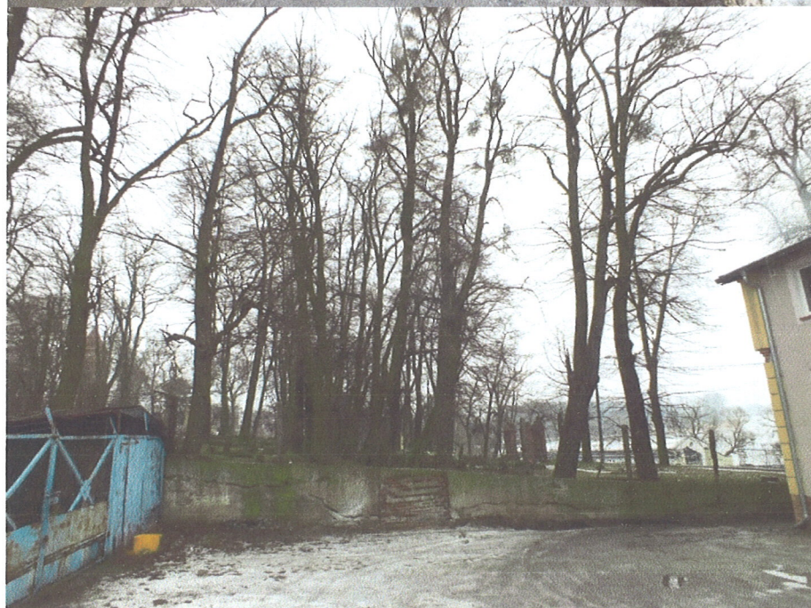
Fot. 23. Mur oporowy na granicy cmentarza z działką zabudowaną, widoczne poziome spękania muru i strzępia muru.
