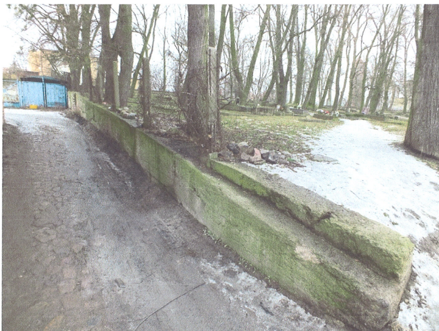
Fot. 22. Mur oporowy na granicy cmentarza z działką zabudowaną, fragment przy wjeździe na posesję, widoczna nadłana ława.
