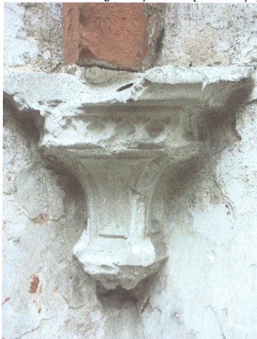
Fot. 60. Gipsowa konsola u dołu spływu żeber sklepiennych.
