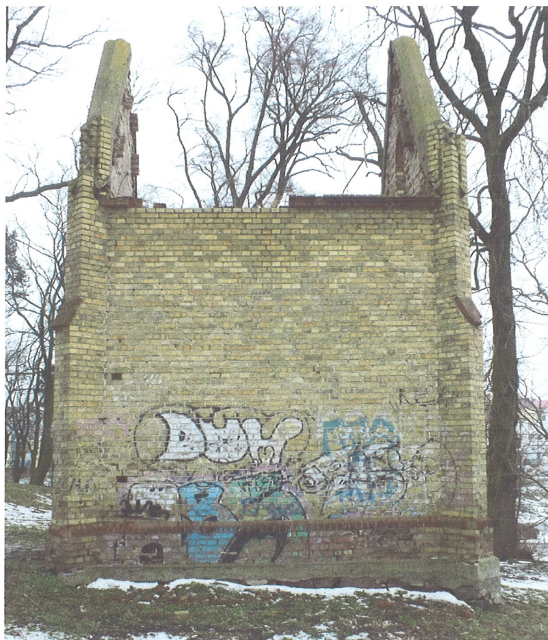
Fot. 51. Południowa ściana kaplicy, widoczne ubytki w sterczynach i gzymsie wieńczącym ścianę boczną.
