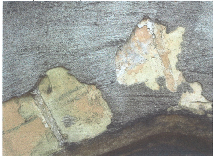
Fot. 55. Fragment łąty cementowej nad otworem drzwiowym. Pod spodem widoczne pozostałości warstwy malarskiej w kolorze zbliżonym do cegły licowej.
