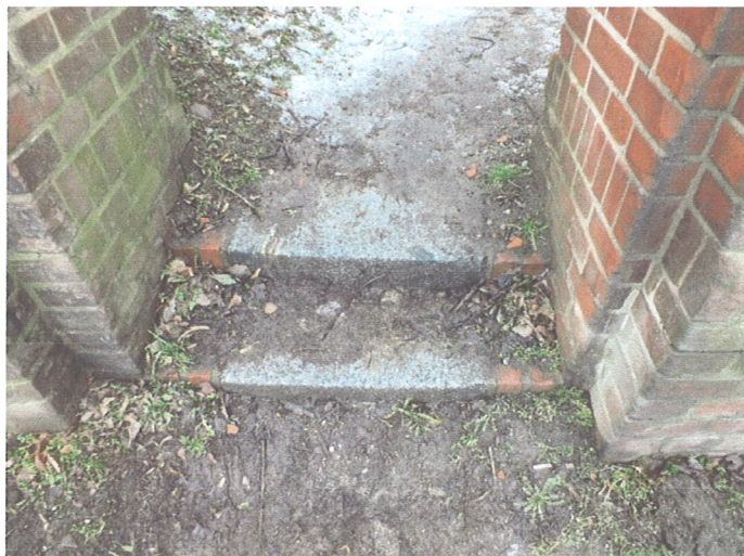
Fot. 38. Granitowo ceglany stopień w furtce.
