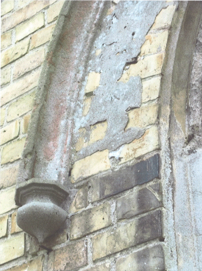
Fot. 53. Dekoracyjny łuk nad otworem drzwiowym – łuk ostry z szyszkami u dołu, widoczna też wtórna łąta tynku na cegle oraz żółta warstwa malarska pod nią.
