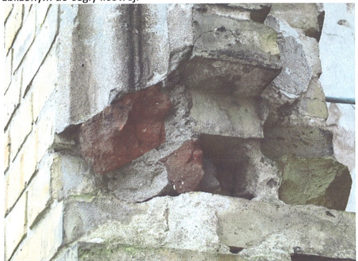
Fot. 57. Dolna krawędź otworu okiennego. Widoczny fragment czerwonej cegły stanowiącej parapet zewnętrzny.
