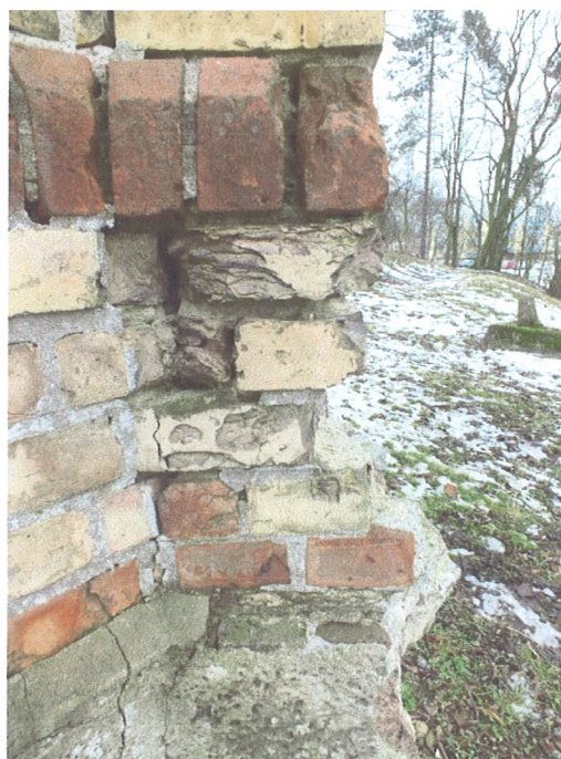
Fot. 59. Zniszczenia cegły i ubytki w obrębie przypory.
