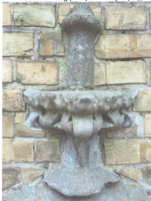
Fot. 61. Kwiaton nad otworem drzwiowym, widoczne fragmenty oryginalne i naprawy z gruboziarnistej zaprawy.
