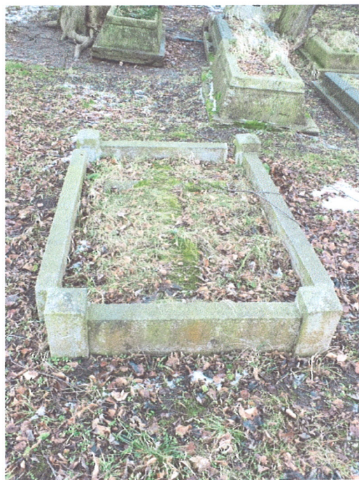
Fot. 20. Obramienia podwójnego pola grobowego ze słupków i krawężników.
