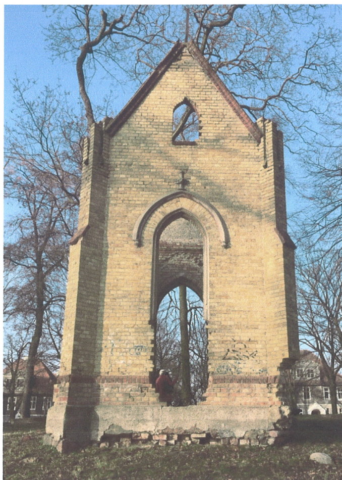
Fot. 48. Elewacja wschodnia. Widoczny otwór okienny z rozebranym fragmentem muru i znaczący ubytek w przyporze.
